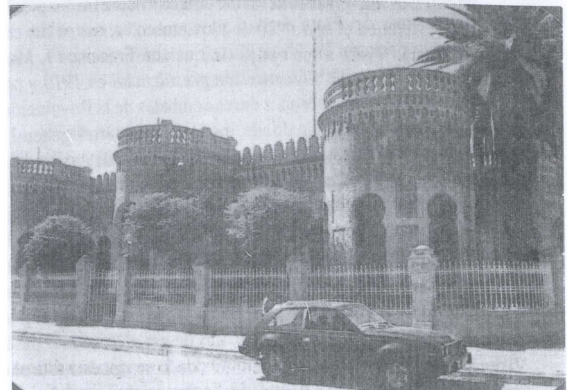
ANTIGUAS CASONAS DE TIPO MORISCO, CONSTRUIDAS A PRINCIPIOS DEL SIGLO XX DURANTE EL AUGE ALGODONERO EN SAN PEDRO.
