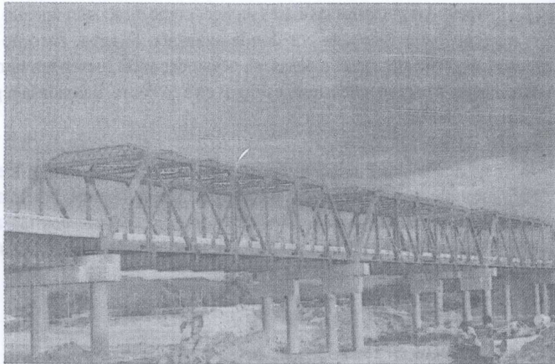
PUENTE SOBRE EL RÍO NAZAS, CONSTRUIDO DESPUÉS DE LA INUNDACIÓN DE 1991, EN SAN MIGUEL.
